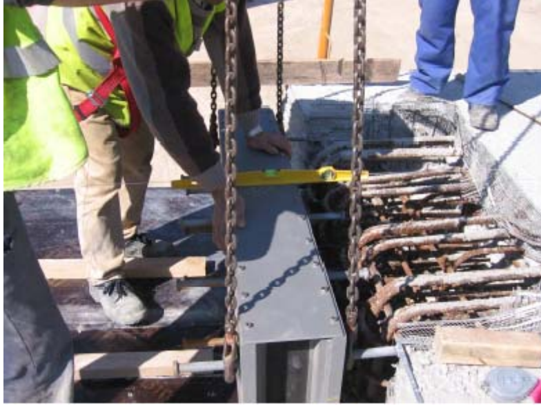
Şekil 9: Merkezleme cihazları olarak gören yapan düşey elastomer mesnetlerin yerleştirilmesi
