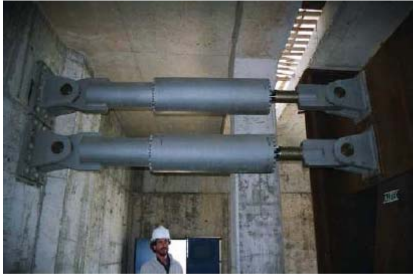
Şekil 7: Arroyo de Las Piedras Viyadüğü’nün hidrolik damperleri / şok ileticileri
